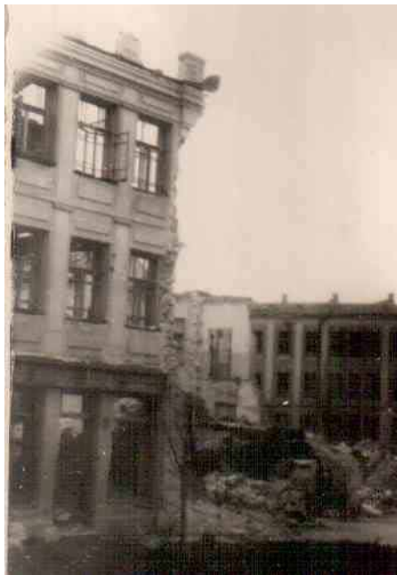
Здание книжного магазина, разрушенного немцами при отступлении в 1943 году, г. Ворошиловград.
