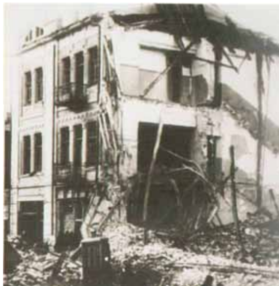
Разрушение на ул. Ленина. г. Ворошиловград.
